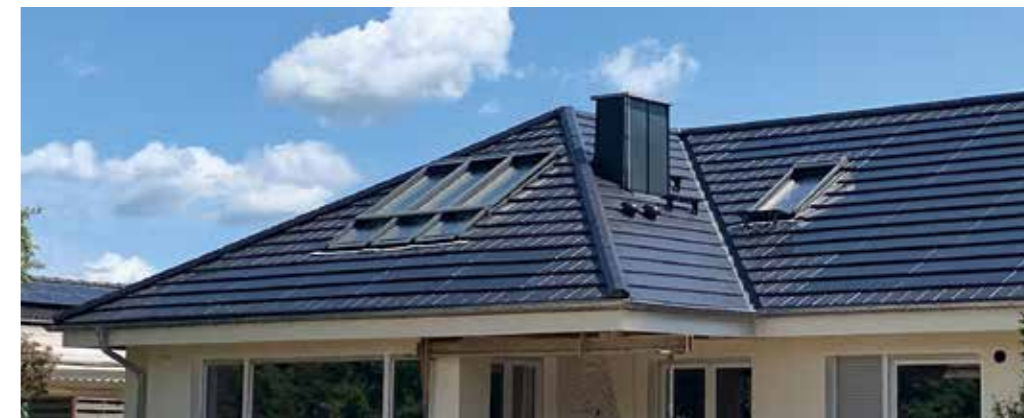
G 10 S PV z dachówką płaską G 10 PRO angobowaną w kolorze starej czerni.
